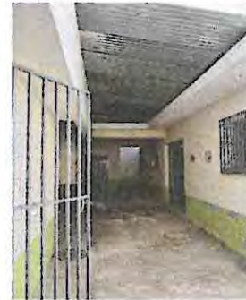
Foto 2: Sustrucción de lámina acanalada por lámina troquelada
