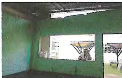
Foto 3: reparación de repello y cernido de paredes
