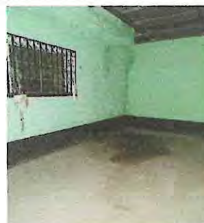
Foto 2: sustitución de piso de concreto por piso de granito
