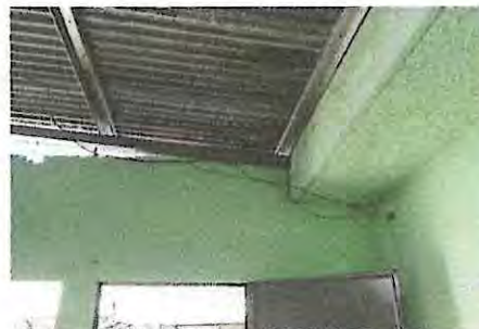
Foto 6: Reparación de cableado eléctrico
