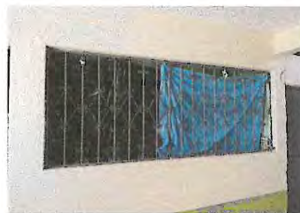
Foto 6: Sustrucción de ventana de pvc
