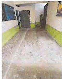
Foto 1: sustitución de piso de concreto por piso de granito
