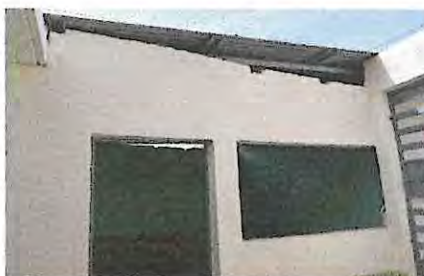
Foto 5: Sustrucción de ventana de pvc
